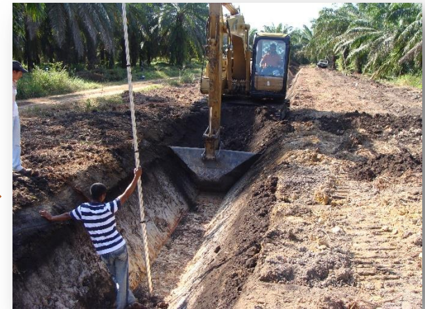
Obras de drenaje
