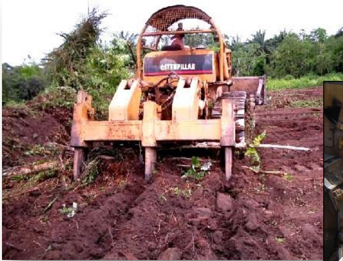
Subsolado en áreas compactadas
