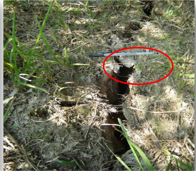
Presencia de grietas en suelos arcillosos (>50% de arcillas)
